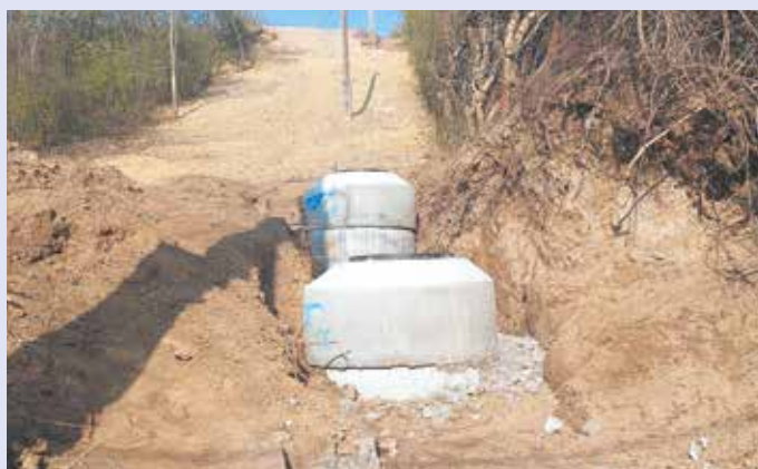
A felszíni csapadékvíz elvezetés projekt első ütemének befejező szakasza
