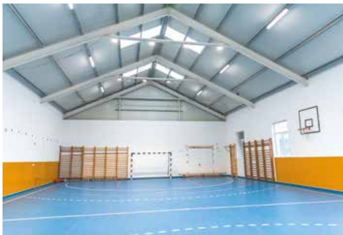
A tornaterem felújítása már elkészült
