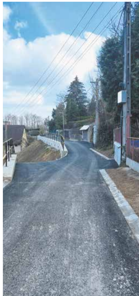
A Hargita utcai partfal súvadás rehabilitációja
