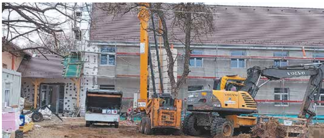
A megújuló iskola kivitelezése jó ütemben halad, már régi tanári épületének bontását is elkezdte a kivitelező
