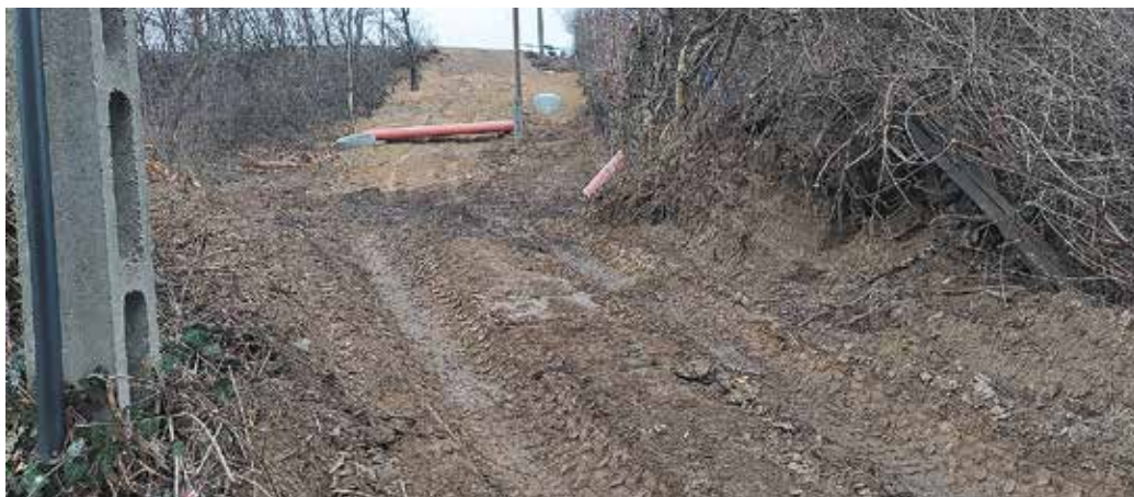
A csapadékvizet majd itt vezetik le a Temető utcából a Dózsa György utcai vízvezető árokba
