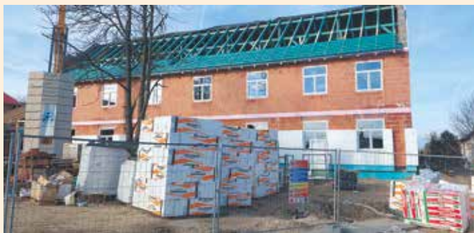
Már megkezdtek a külső szigetelést, és hamarosan lezárják a tetőt
