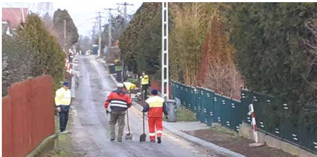
Csapadékvíz-elvezető rendszer fejlesztés első üteme során a Deák Ferenc utca első szakasza elkészült, a Bartók Béla és a Temető utcában ütemterv szerint zajlik a kivitelezés
