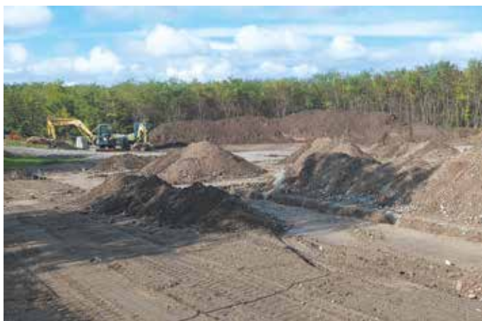
Az új bölcsőde épületénél jelenleg az alapozási munkálatok folynak
