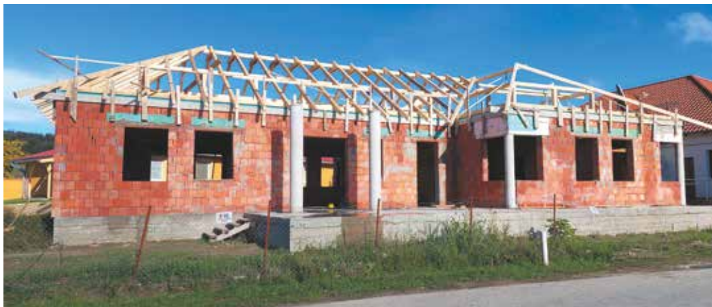
Az egészségház bővítésének munkálatai újra megindultak
