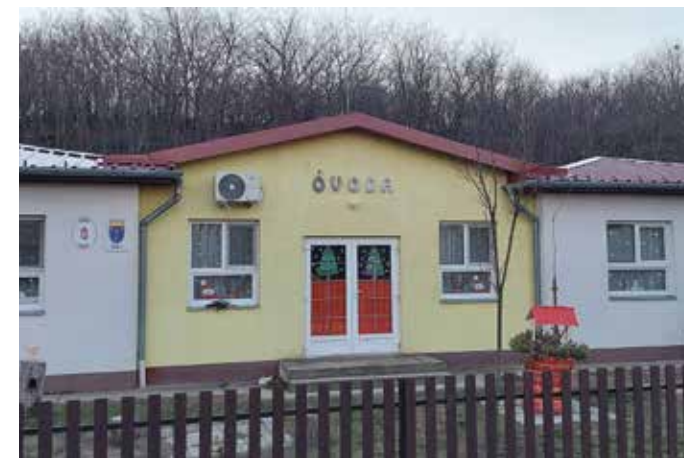
Az állandóan beázó, korszerűtlen, fizikailag leromlott tetőszerkezetét cseréltük le
