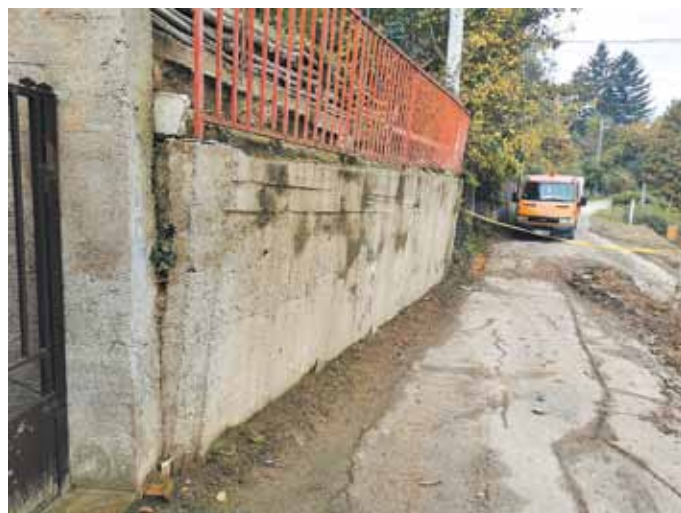
A partfalmozgás látható jelei
