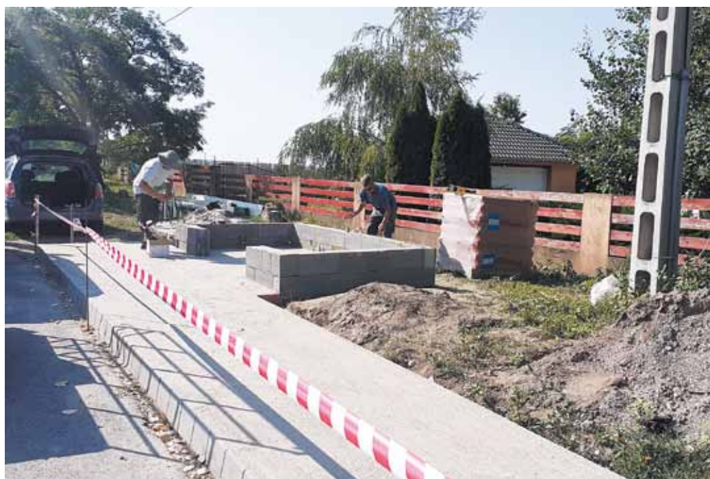
A Plate Work Kft kivitelezésében készülnek a buszmegállók
