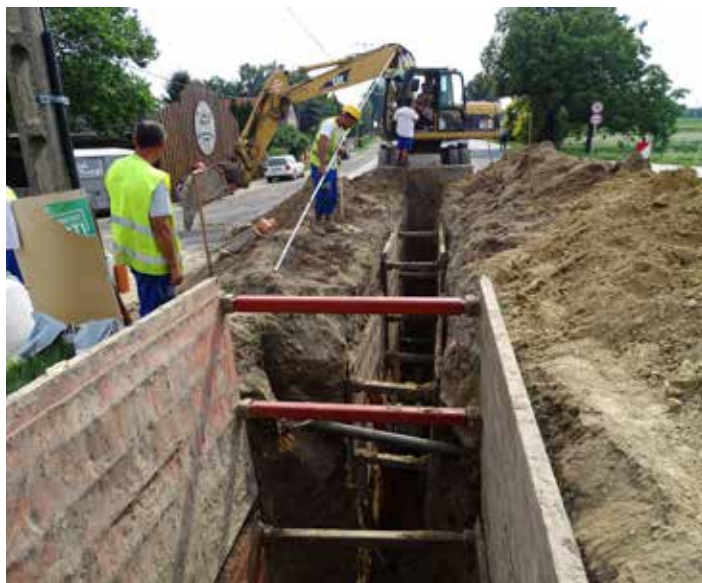
A földre festett sárga nyílnak és a jobb felső sarokban látható ugyancsak sárga, gázvezeték jelölő táblának kellene egy vonalban lennie... Az ilyen apró eltérések jó esetben csak több órás csúszást okoznak
