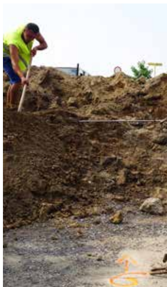
A földre festett sárga nyílnak és a jobb felső sarokban látható ugyancsak sárga, gázvezeték jelölő táblának kellene egy vonalban lennie... Az ilyen apró eltérések jó esetben csak több órás csúszást okoznak
