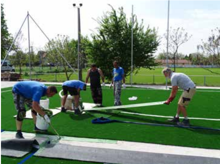
Az utolsó simítások, pontosan, összehangoltan. Kedden a műfü takarót szabták és ragasztották, szerdán a homokot terítették. A szórógépen Ivánka Ernő, a csapat vezetője
