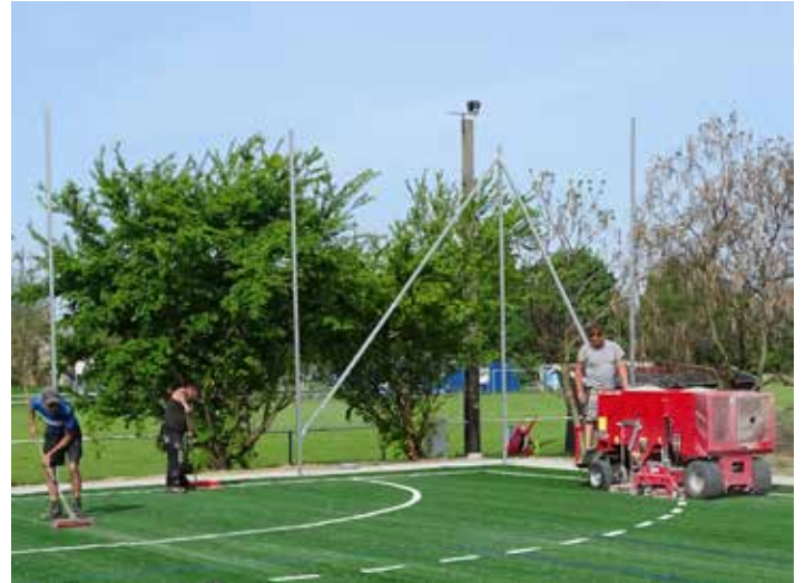
Az utolsó simítások, pontosan, összehangoltan. Kedden a műfü takarót szabták és ragasztották, szerdán a homokot terítették. A szórógépen Ivánka Ernő, a csapat vezetője
